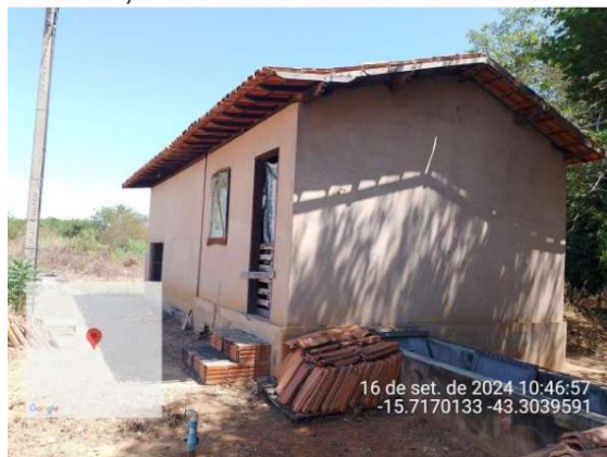
Foto 02, casa de bomba + casa colono
