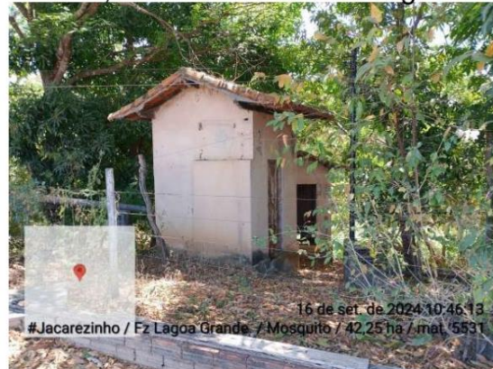
Foto 03, casa de bomba na margem rio
