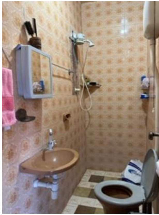
Vista do banheiro social na edificação de fundo de nº 75f.
